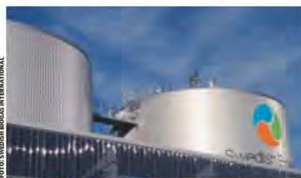
Swedish biogas anläggning i Örebro har spritt dålig lukt.
