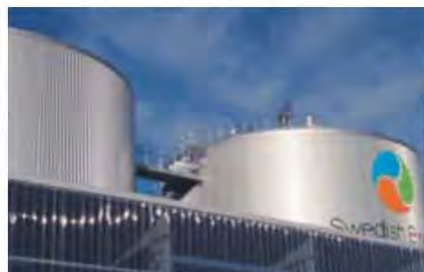
Biogasfabriken i Örebro. På bilden, har spridit dålig lukt i sitt närområde. I Älta fortsätter kampen mot ett liknande bygge.
