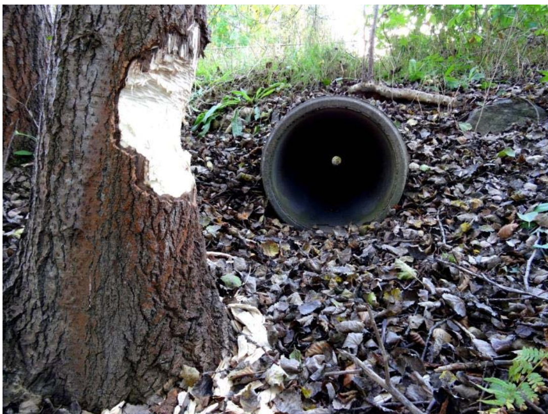
Fig. 12. Vägtrumman under cykelbanan.
