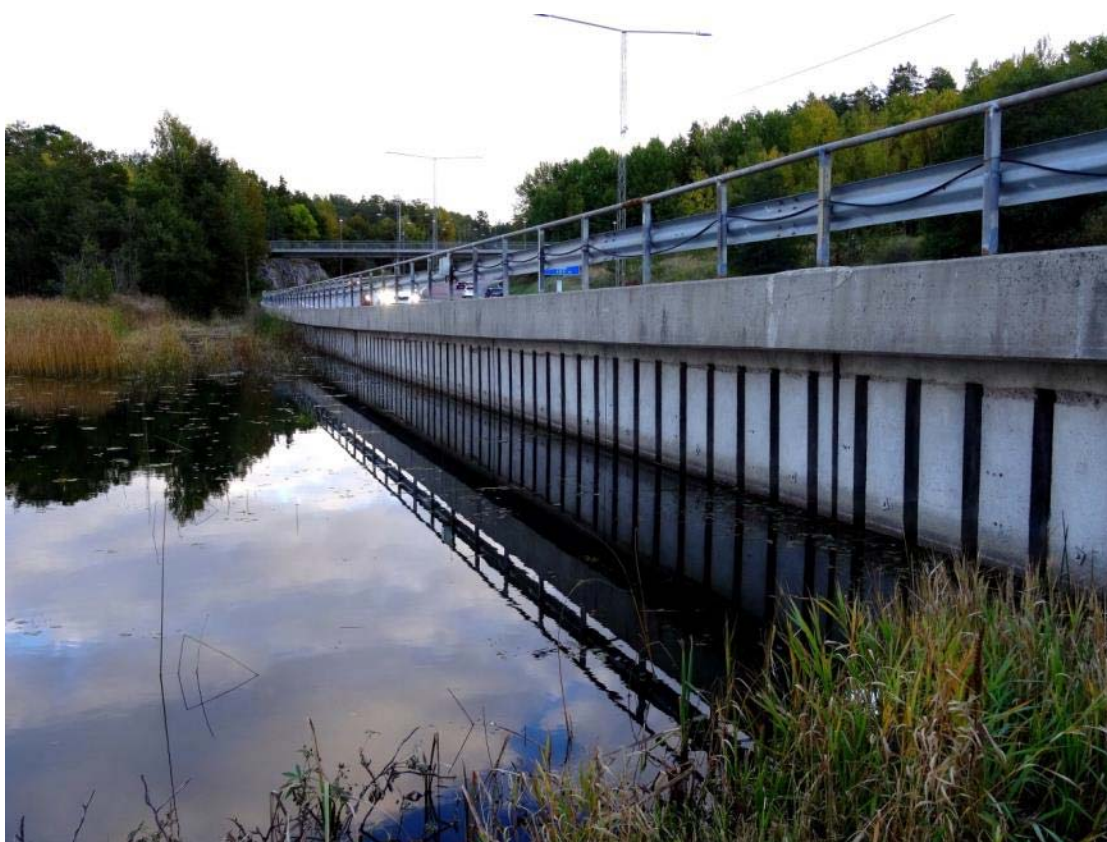
Fig. 7. Den pålade betongkanten med tillhörande spjälor sedd från norr.
