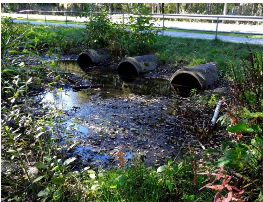
Fig. 13. Vägtrummor under Ältavägen
