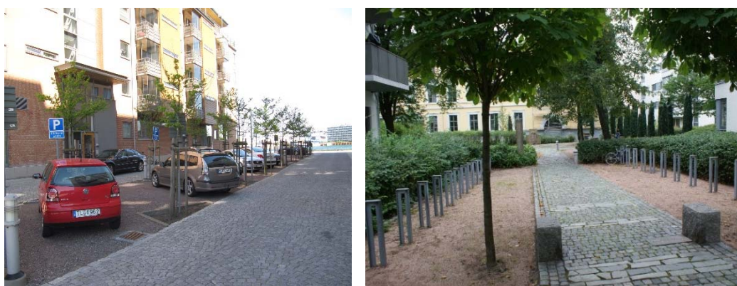
Figur 7 Exempel på permeabla beläggningar.
