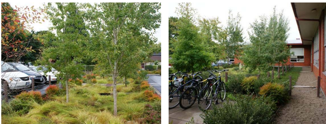
Figur 12 Exempel på utformning av regngårdar vid en grundskola. Avvattning sker från omgivande parkeringsytor och tak.
