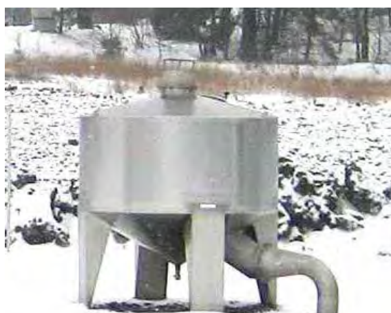
Figur 5 Aktiv kolfilter vid Norrköping biogasanläggning
